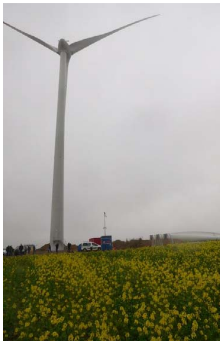
Un premier mât déjà construit, un deuxième se profile au loin. Pour novembre, les six éoliennes tourneront dans le vent d'hiver. © J.-P. DV.
